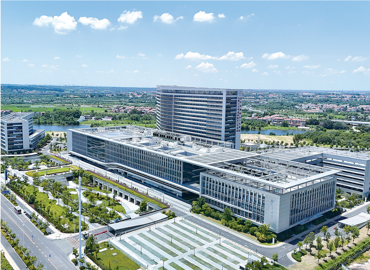
航拍黄陂区人民医院。
