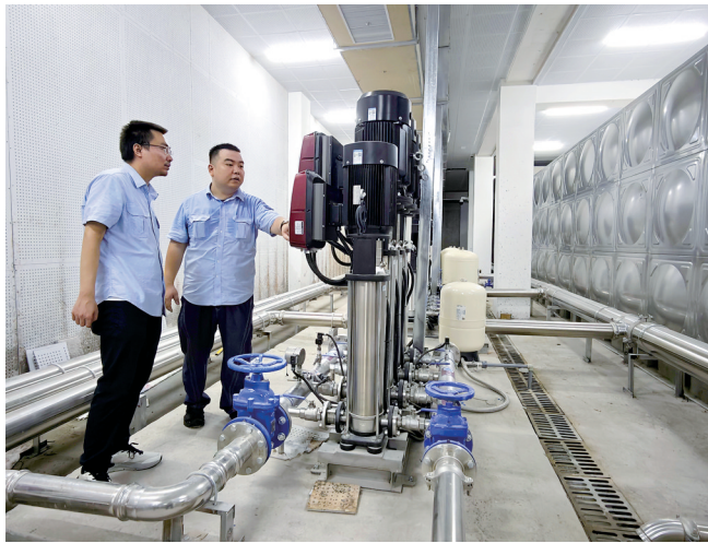
供水人员在新集·年华里小区地下泵房巡查。
