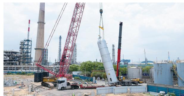
航煤加氢装置安全提升改造工程项目核心设备——液相加氢反应器吊装就位。
