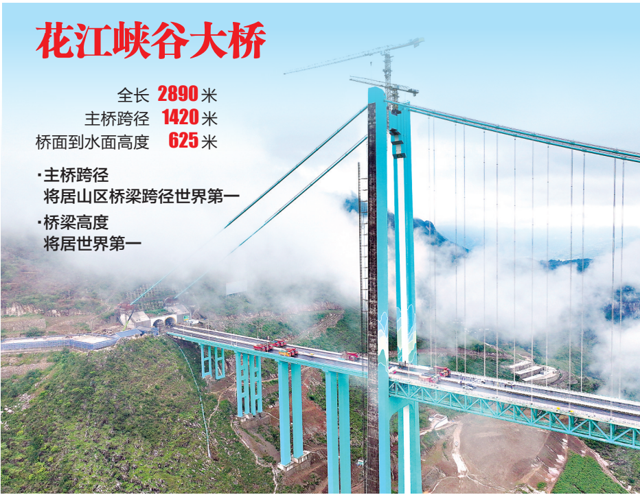
8月21日拍摄的贵州花江峡谷大桥荷载试验现场（无人机照片）。
