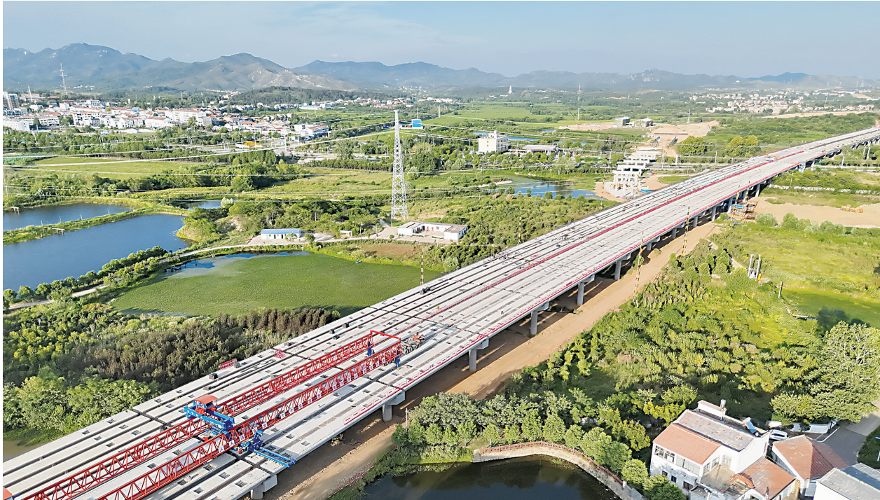
8月24日，武汉都市圈环线高速公路跨木兰大道高架桥全幅贯通。
