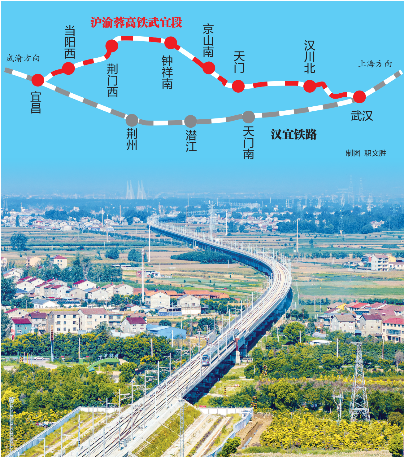
8月26日,55402次试验列车即将驶入沪渝蓉高铁武宜段钟祥南站。
