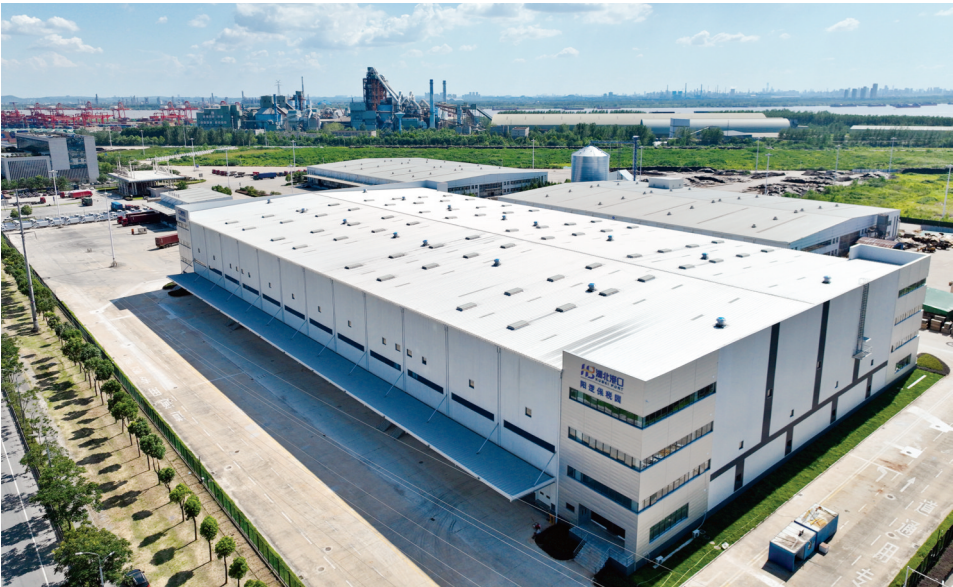
武汉新港空港综保区国际货物集散中心全景。
