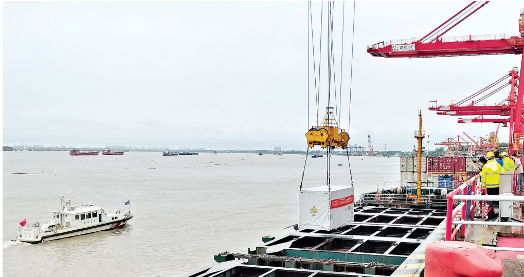
储能柜吊装上船。
