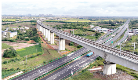
襄阳东站双线特大桥。 通讯员包健 摄
