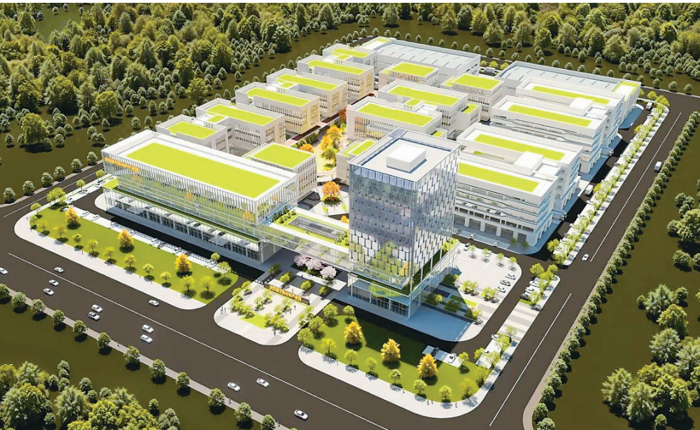
武汉航空新材料产业园一期项目年底建设完成。
