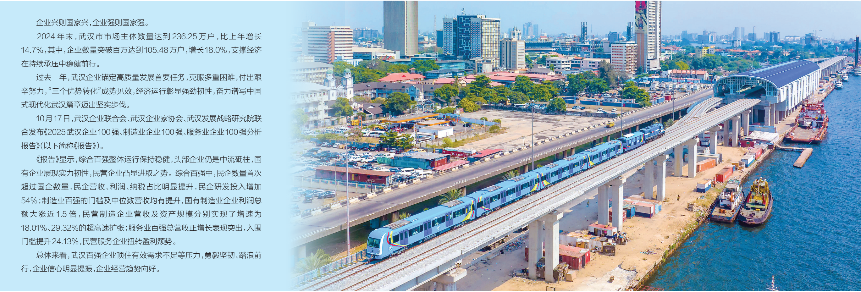
铁四院勘察设计的西首条电气化轻轨——尼日利亚拉各斯轻轨蓝线一期工程竣工。
