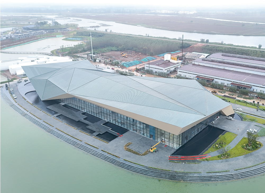
沉湖国际小镇永久会址屋顶完工。
