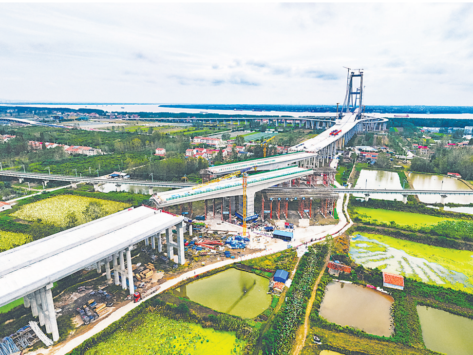
万家咀大桥正在转体。
