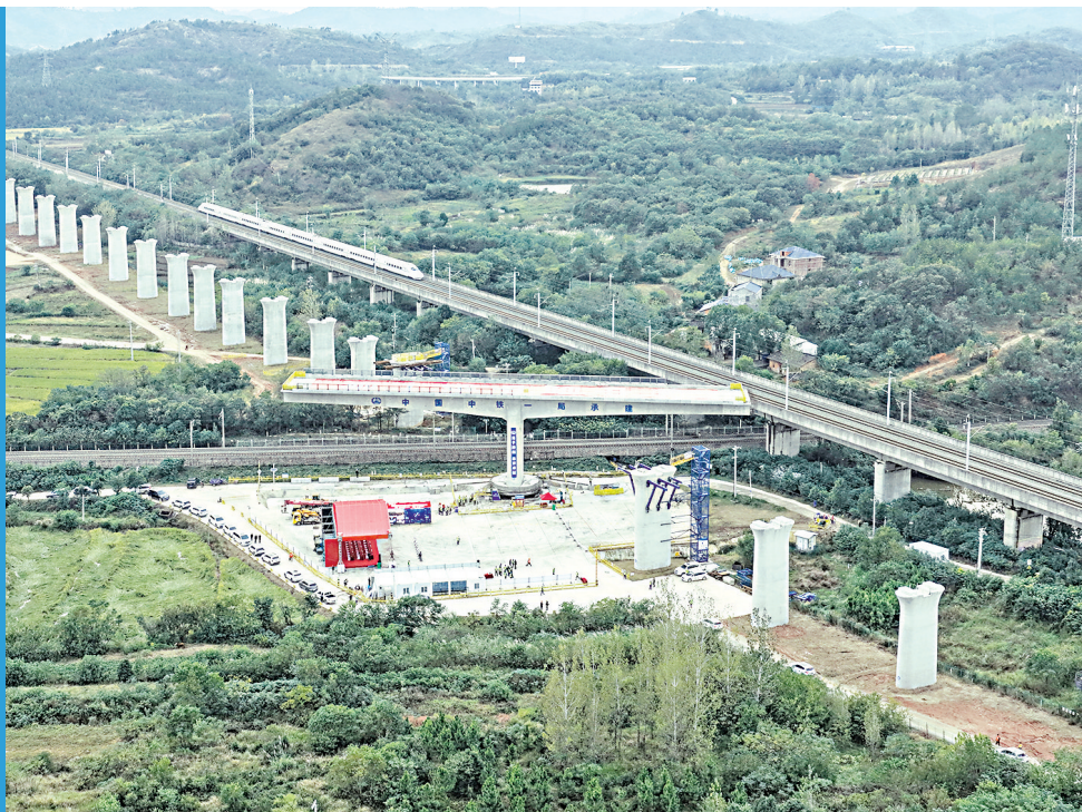
沪渝蓉高铁合武段跨京九铁路特大桥66号墩T构转体连续梁现场。
