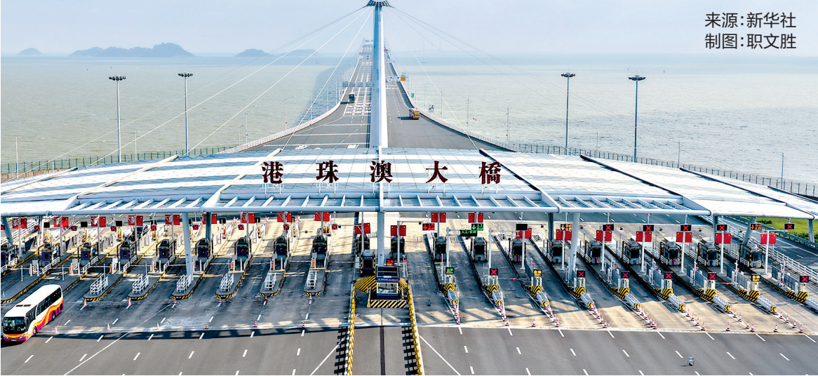
港珠澳大桥入口(无人机照片)。
