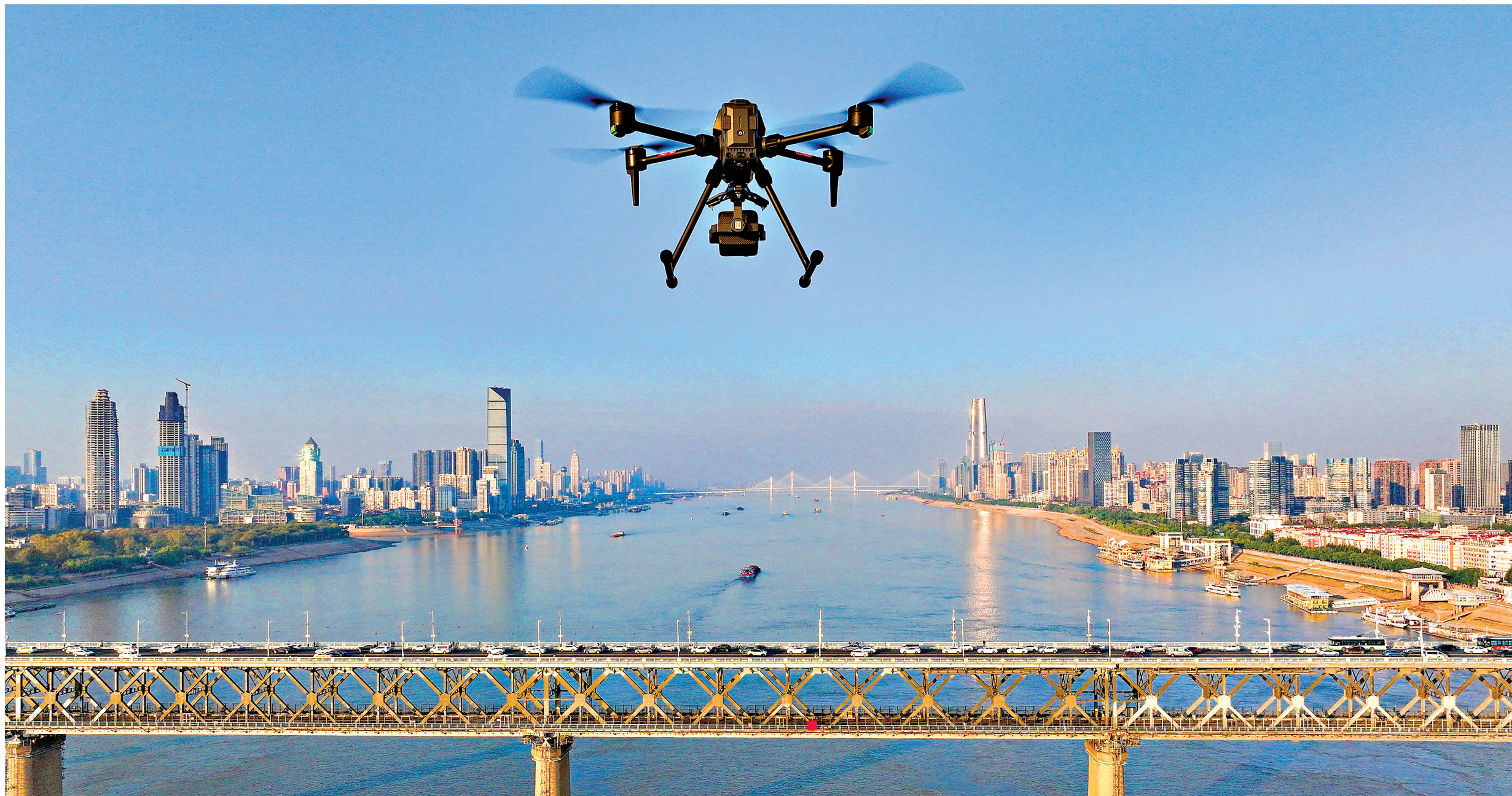
普宙科技无人机在武汉长江大桥上空往上、下游方向进行测绘、巡检。
