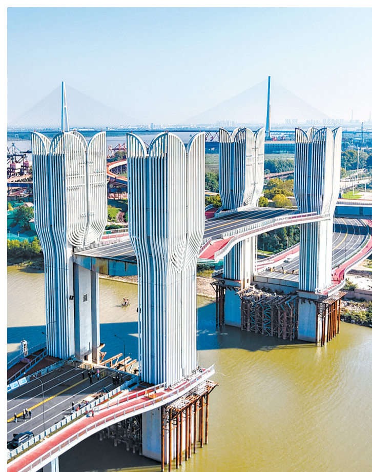
右岸大道开启桥亮相,汛期时桥面乘“电梯”可提升至27米高。 通讯员李晟峰 摄
