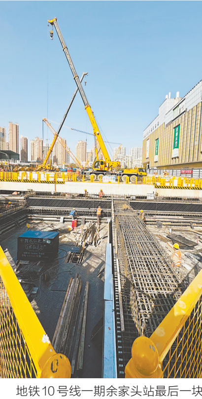
地铁10号线一期余家头站最后一块顶板施工。长江日报记者陶常宁 摄
