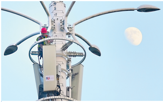
夜幕降临,武汉电信工作人员在检修维护信号塔。
