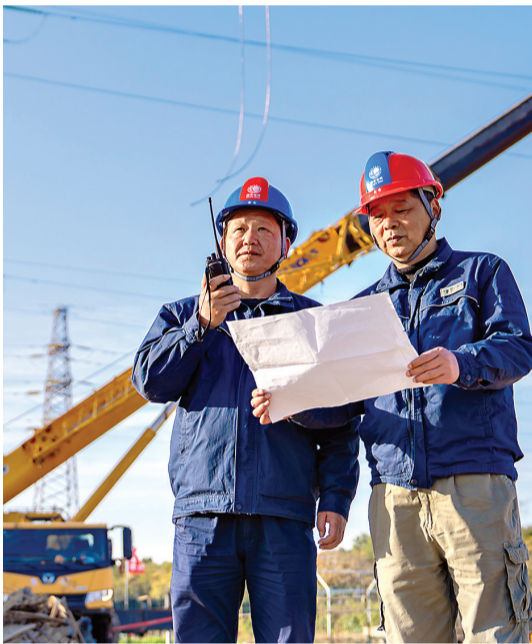
11月30日，220千伏徐湾一二回线路改造工程正式投产送电。
