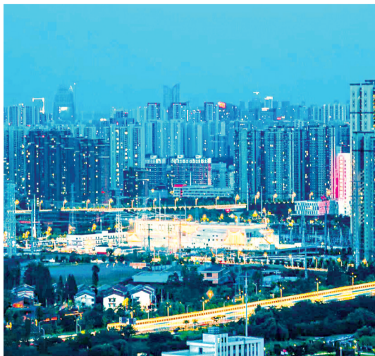
华中首座500千伏全室内变电站在汉投运。
