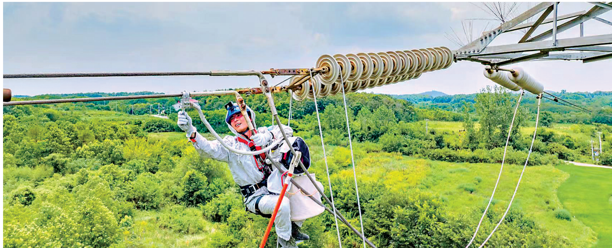
国网武汉供电公司输电运检人员在220千伏岳孙一回高压输电线路开展紧急“消缺”施工。
