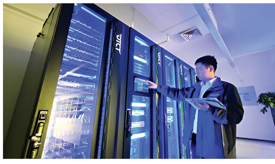
上图:德塔森特正在使用的企业级数据中心规模很小,4台机柜像搭积木一样连起来就能用。 长江日报记者秦琛 摄
