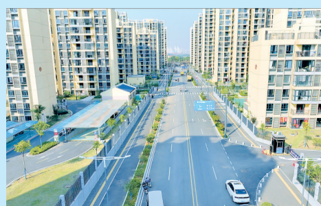
一批市政道路项目顺利通过竣工验收。
