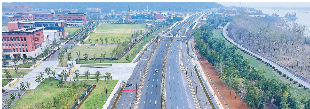
中交城投投资建设的左岸大道(枫林六路—兴七路段)。
