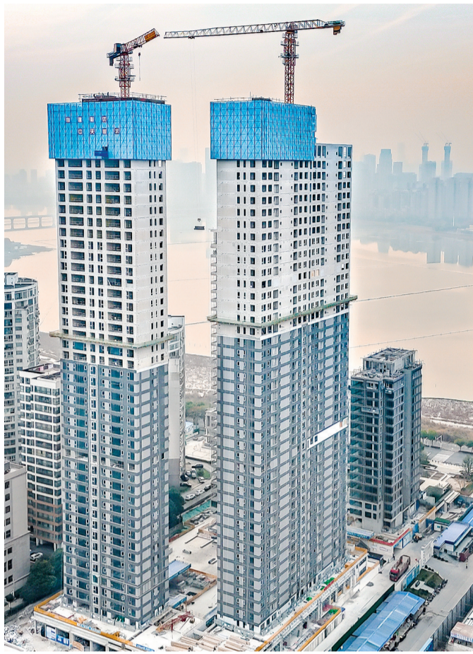
沙湖天境项目,工地不见飞扬的尘土,建设过程犹如搭积木一样高效便捷。
