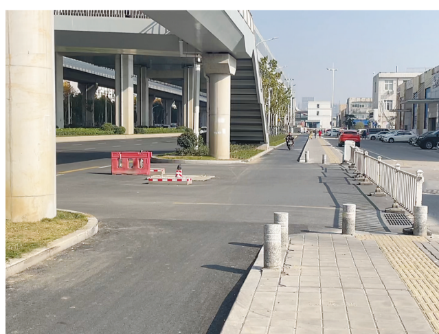
涉事占道道闸已拆除。
