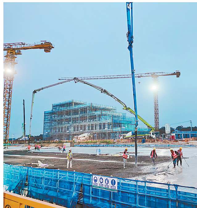
清水池混凝土浇筑现场。
