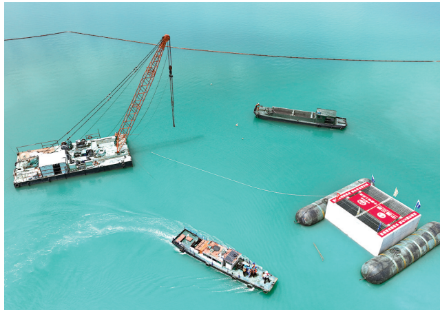
取水头部施工现场,210吨的取水头部“乘”着气囊实现精准安装。
