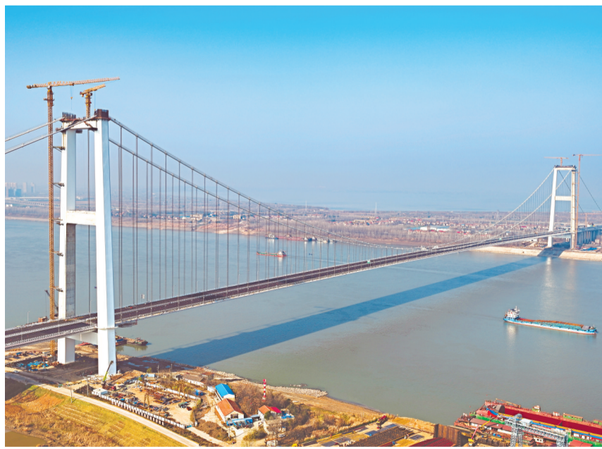
双柳长江大桥主桥航拍。
