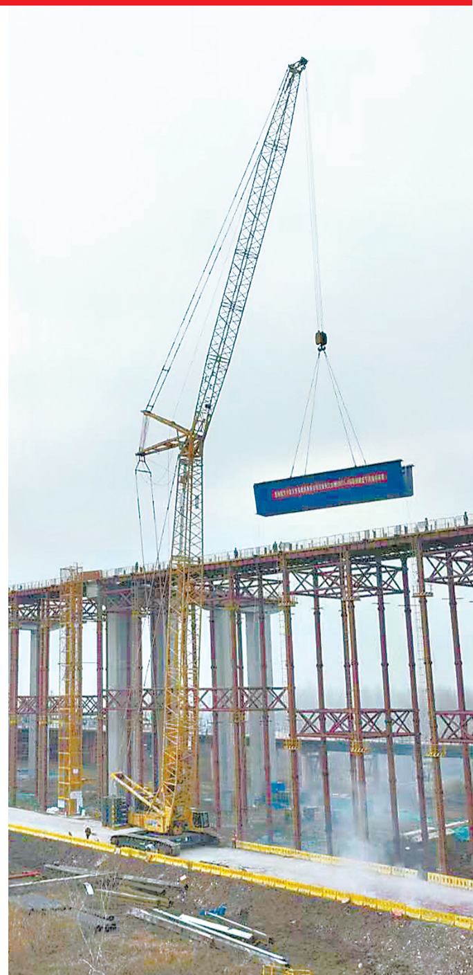
汉南长江大桥北岸滩地引桥钢梁正在架设。通讯员徐瑞坤 摄
