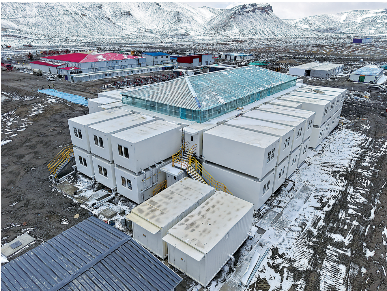
“高原好房子”新疆火烧云铝锂矿增压建筑群项目。
