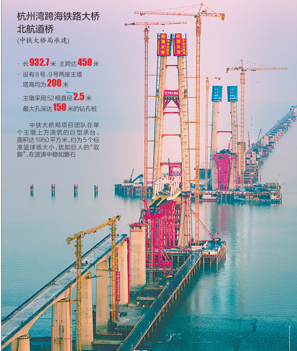
杭州湾跨海铁路大桥北航道桥高达200米的8号主塔成功封顶。
