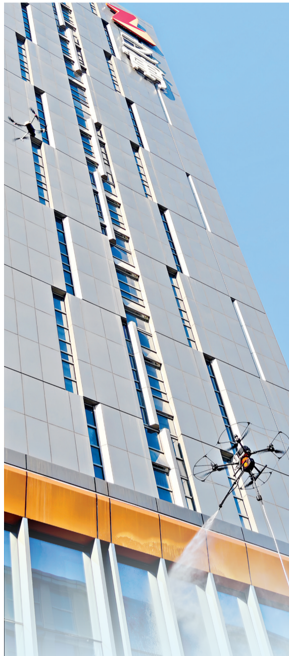
科技物业使用无人机清洗玻璃幕墙。
