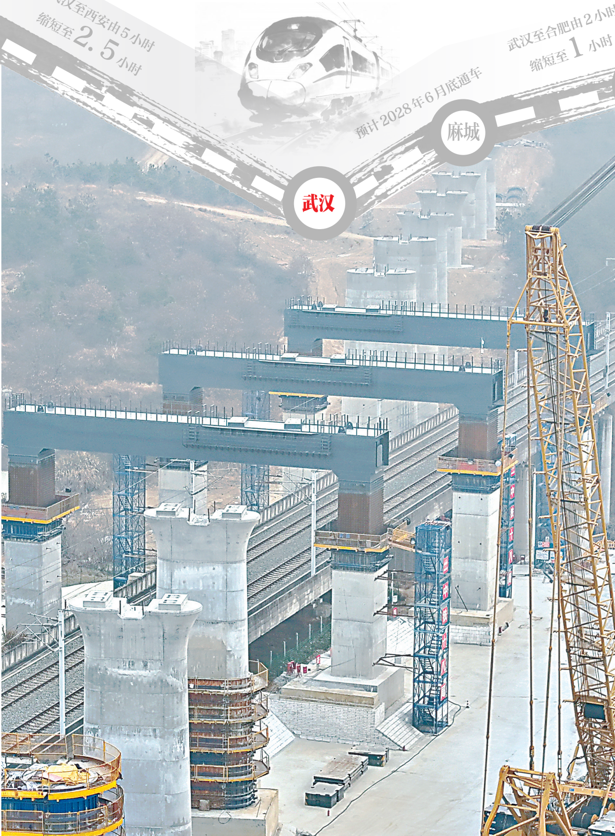
合武高铁雷家冲特大桥钢盖梁吊装完成。
