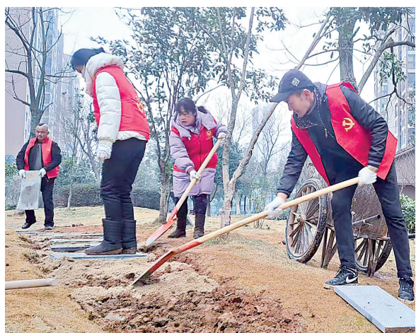
星芯社区居民参与铺设便道。
