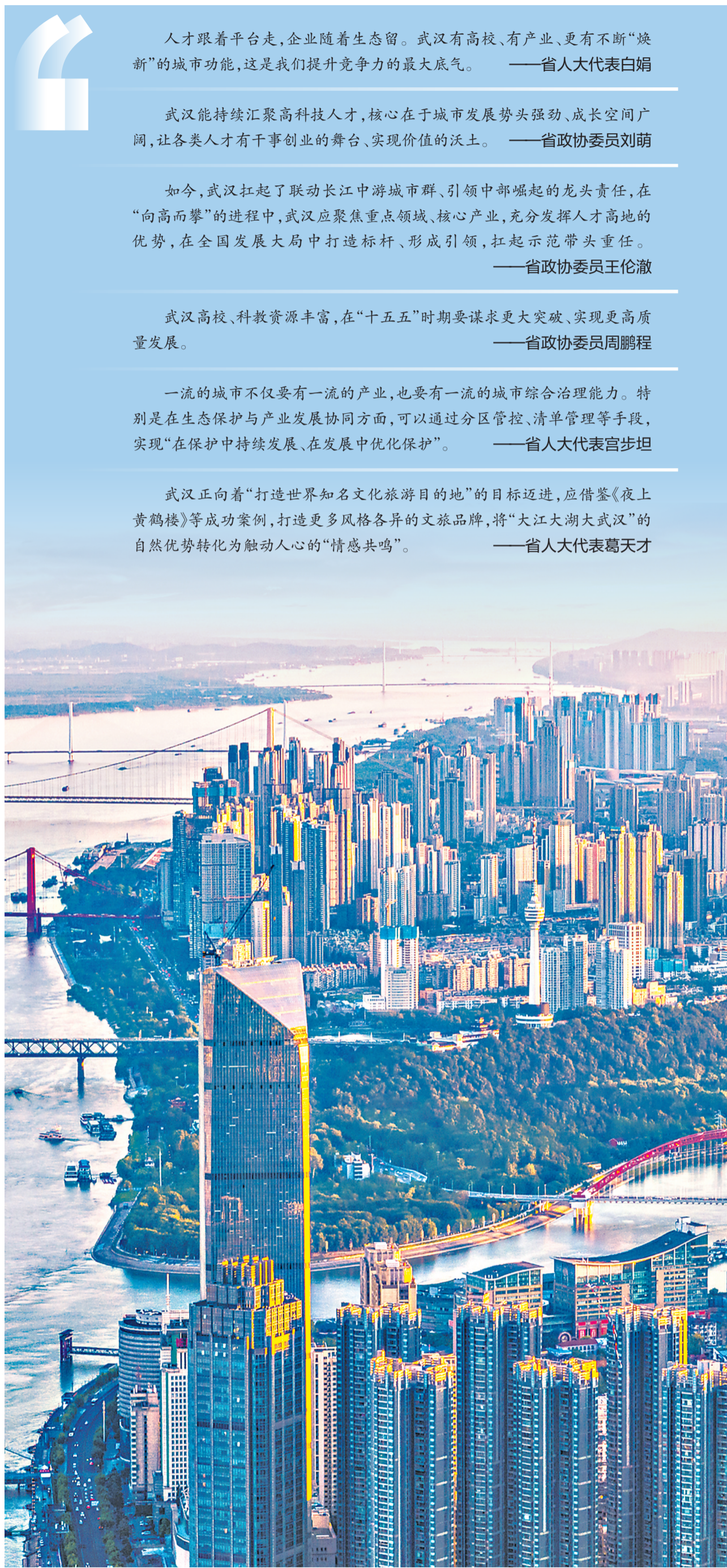
高空俯瞰南岸嘴。
