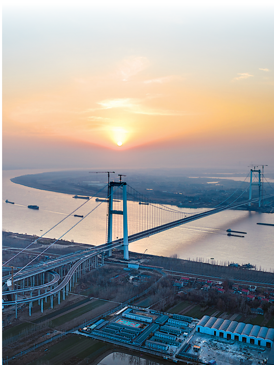
2025年12月31日,双柳长江大桥通过交工验收。
