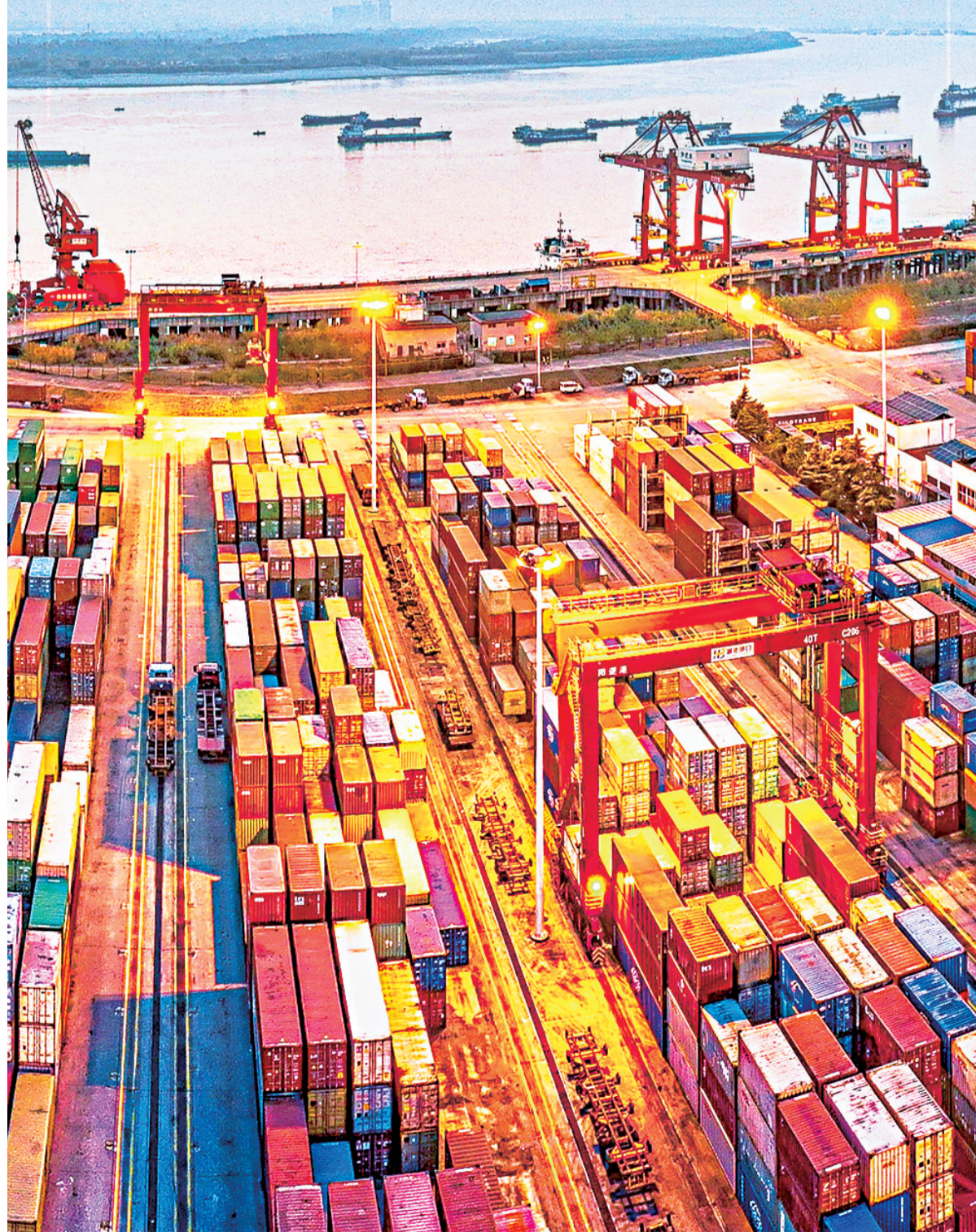
武汉阳逻港水域,阳逻港集装箱码头吊吊林立,装运生产、生活物资的船舶穿梭往来,一派繁忙景象。新华社记者肖艺九 摄
