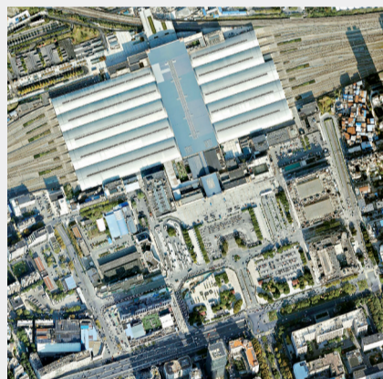
2024年,航摄影像下的汉口火车站轨道纵横、楼宇林立。
