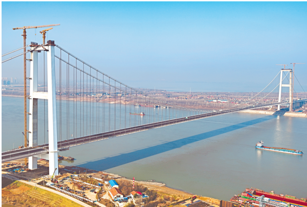
双柳长江大桥通过竣工验收。通车后,武汉新洲到鄂州只需5分钟,将加快武汉都市圈一体化发展。 通讯员杨鑫 摄
