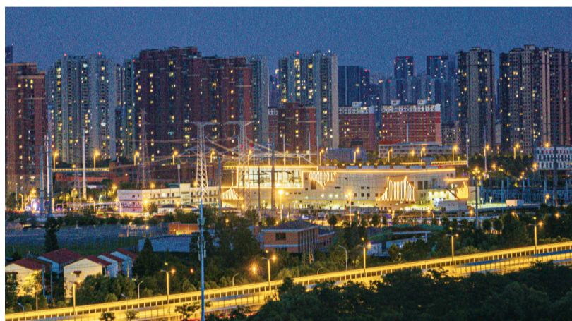
华中首座500千伏全室内变电站——500千伏金银湖变电站。
