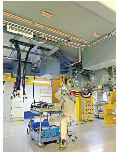
工人正在进行接线作业。 长江日报记者占思柳 摄
