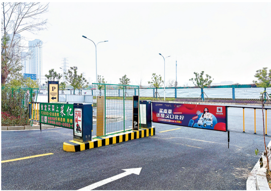
紫郡兰园小区一期开通的新道口。
