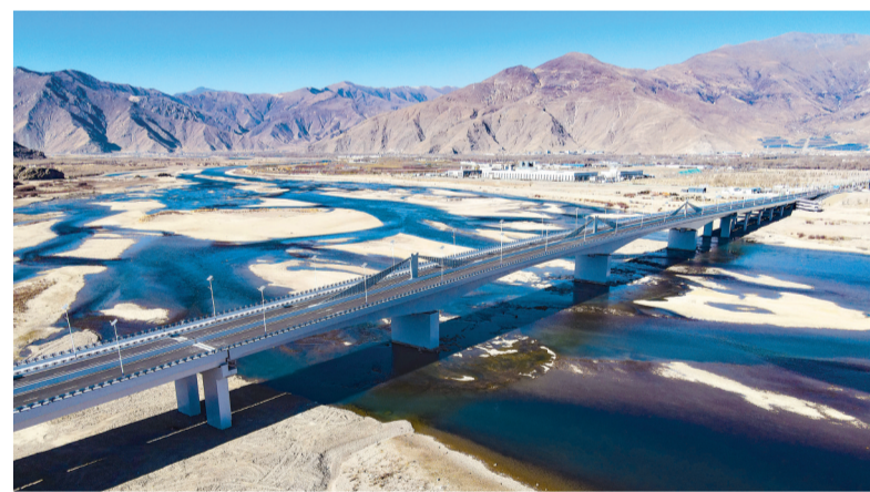
拉萨聂当特大桥建成通车。 通讯员 焦猛 摄
