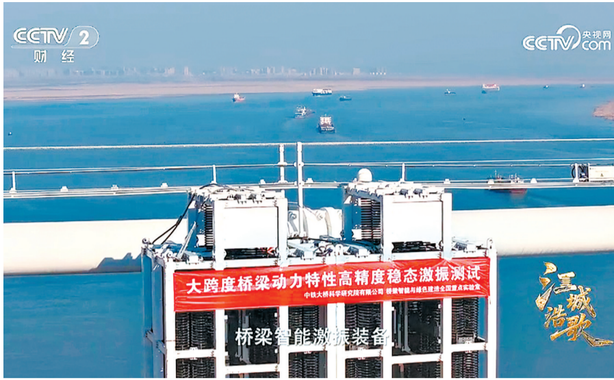
桥梁智慧运维。(央视截屏)
