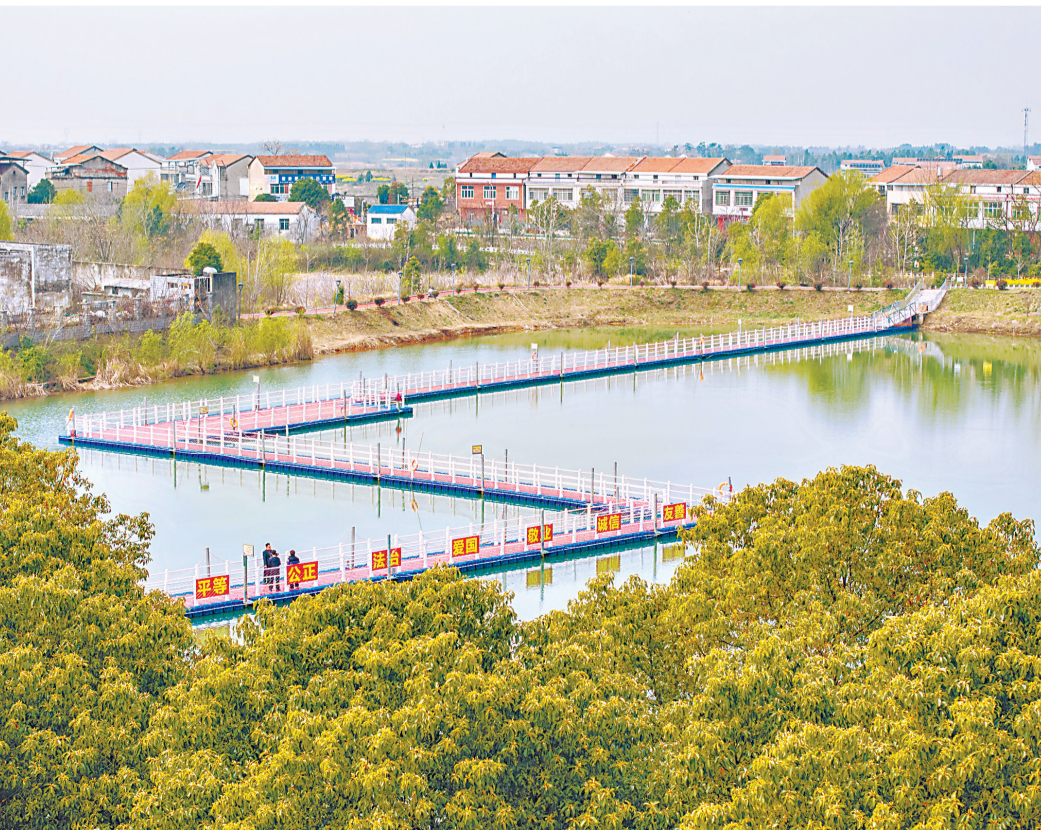
“彩虹浮桥”横跨水库水面。
