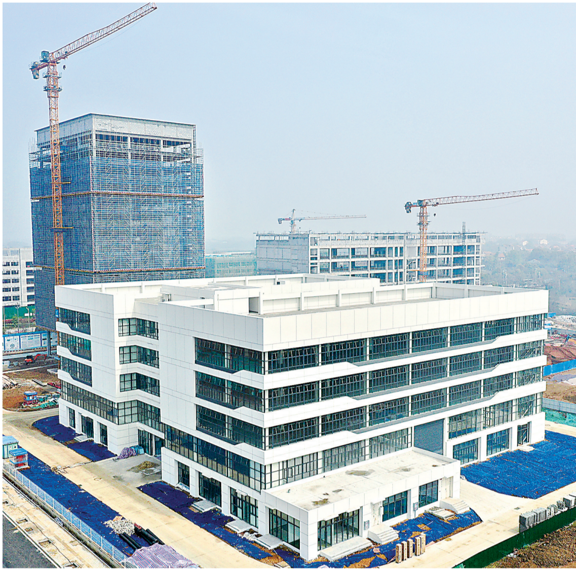
武汉航空新材料产业园部分楼宇即将竣工交付。
