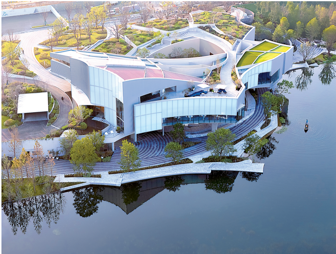
麓洲艺展中心与麓湖通过玻璃幕墙衔接。
