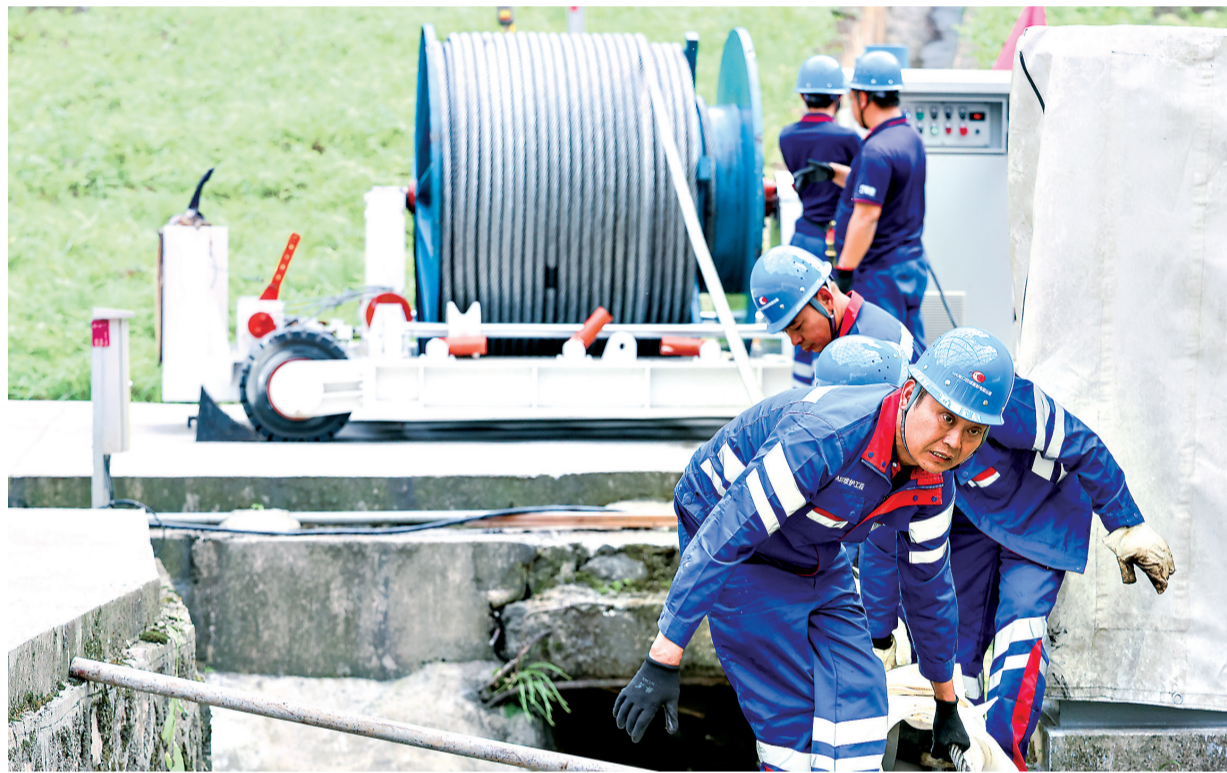
5月6日,工作人员将馈源驱动钢丝绳装入卷扬机。
