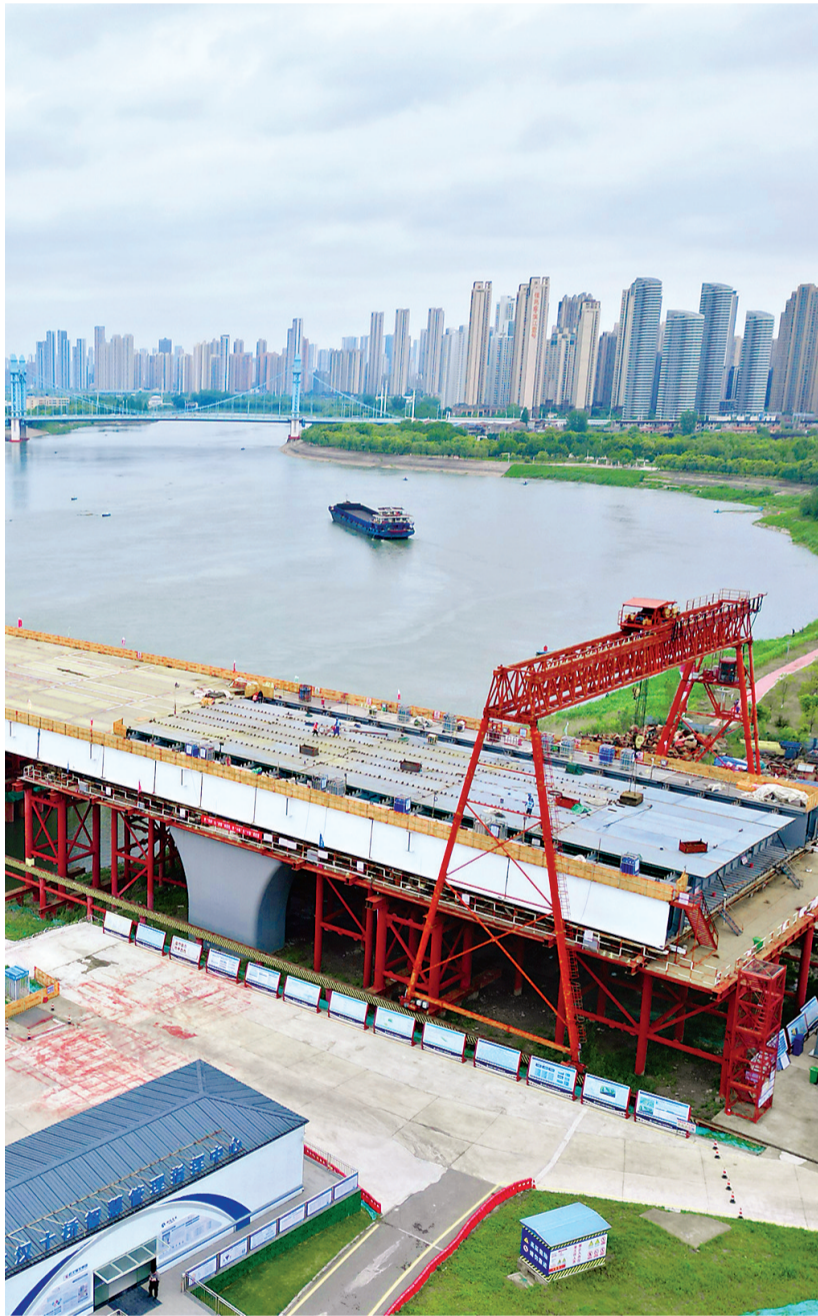
建设中的江汉十桥。 施工单位供图
