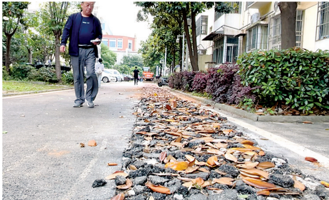
居民盼望小区二次供水改造工程早日完工。
