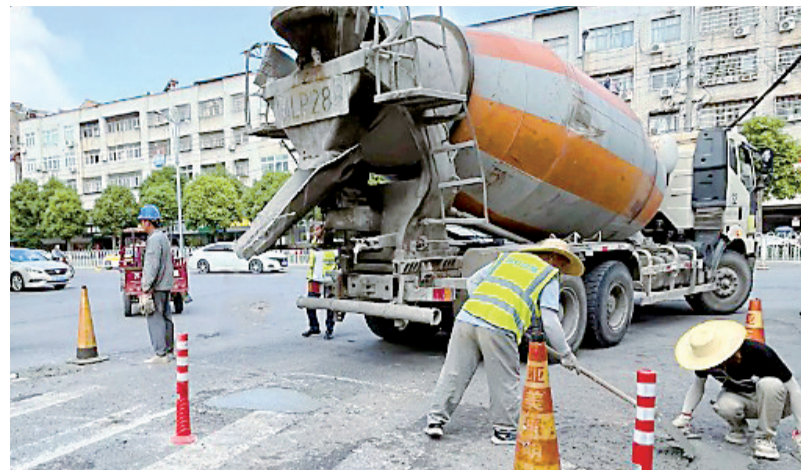
石墩被拆除后，施工人员用混凝土抹平其原先所在位置。
