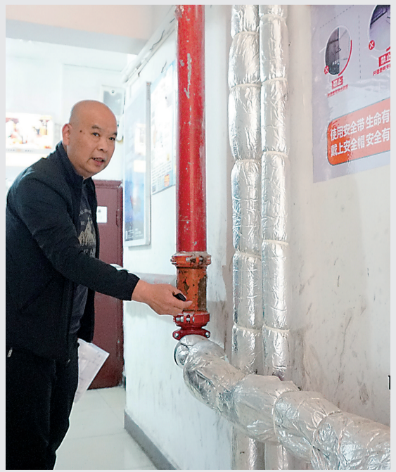
工程人员唐金佑正在检修管道。 长江日报记者秦璟 摄
