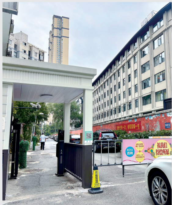
沙湖金港苑小区大门翻新。 栾嘉雯 摄
